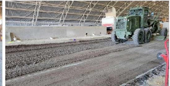
(d) Grading with a motor grader
